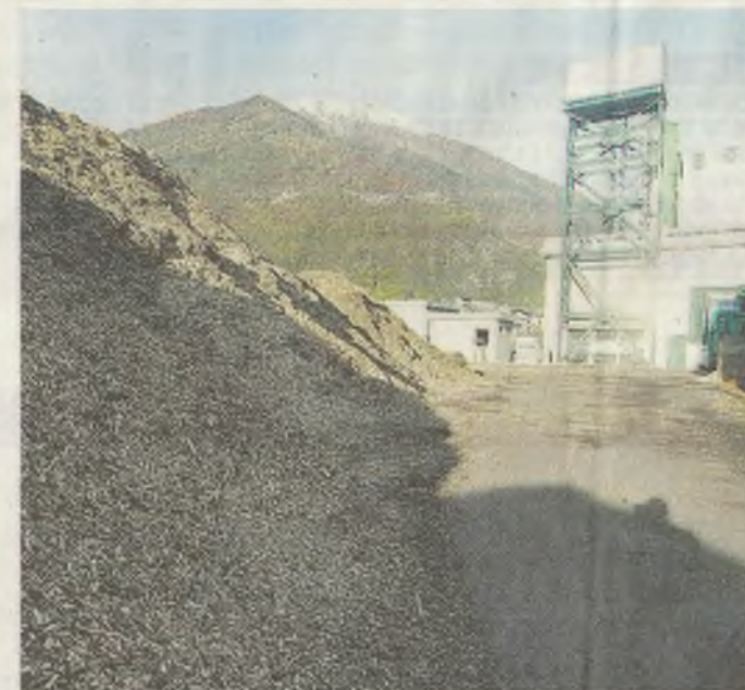
La centrale di teleriscaldamento
