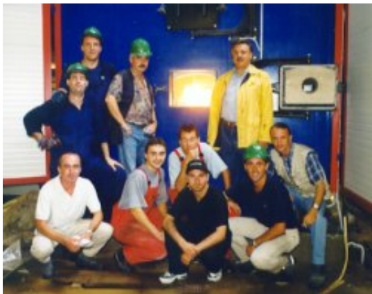
foto di gruppo all'avvio della centrale di Tirano
